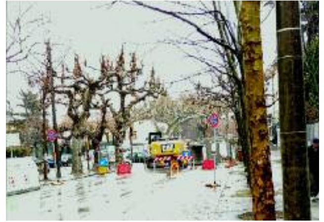
Nella foto i lavori di sistemazione della piazza davanti alla stazione FS
