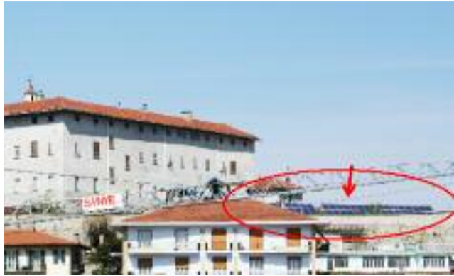
I pannelli solari nel giardino del Monastero
