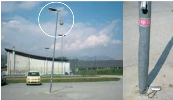
Il lampione e nel riquadro la base del palo e, all'interno un cavo elettrico a vista?
